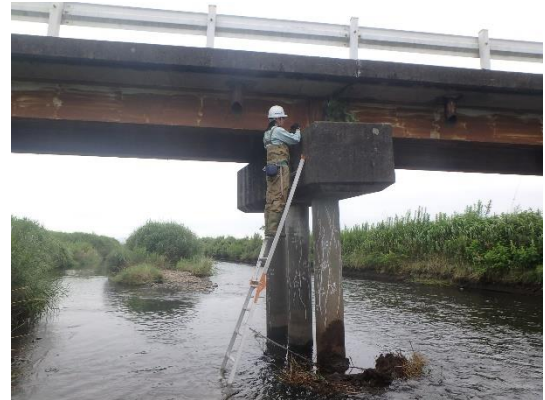
写真 1-3-2 梯子による点検(大和田橋)
