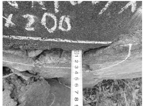
地覆断面修復工
