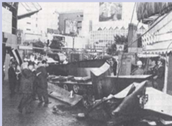
台風で落下した時の様子
