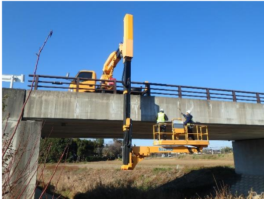
写真 1-3-1 橋梁点検車による点検(大沢橋)
