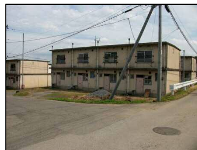
東田井町営住宅
