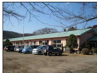
友愛作業所（廃校跡地【大羽小学校】）
