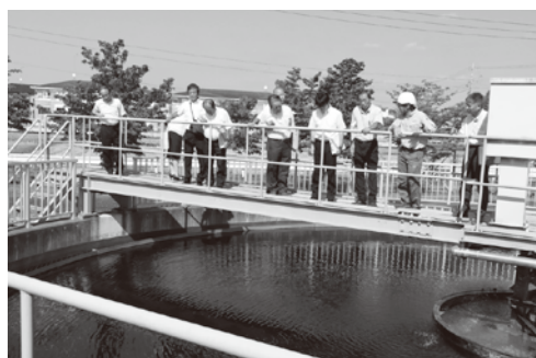
益子浄化センター 現地調査の様子
