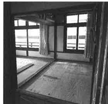
平成館改修工事現地調査
