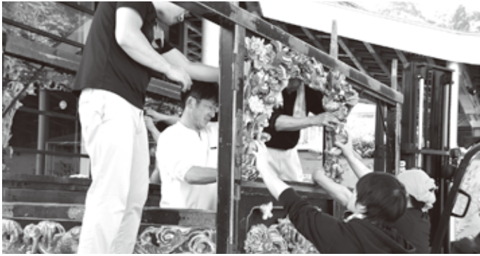
屋台解体作業のようす
