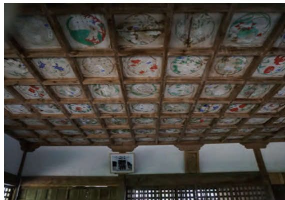
写真 3-78 山本八幡宮拝殿天井
