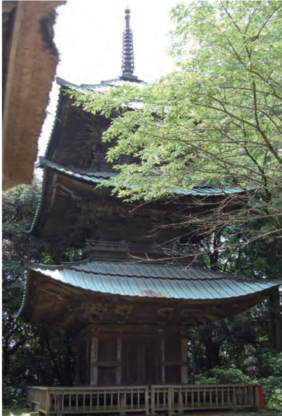
写真 3-28 西明寺三重塔
