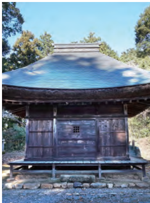
写真 4-13 地蔵院観音堂
