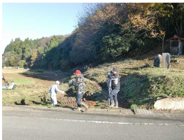
支柱用の鉄筋も結構重い！
