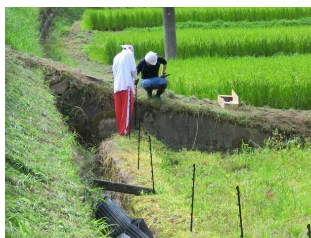
設置作業開始 支柱打ち込み
