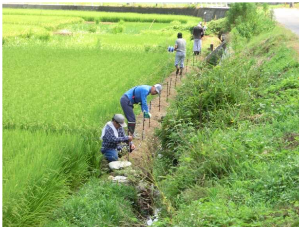
支柱に電牧線を架設
