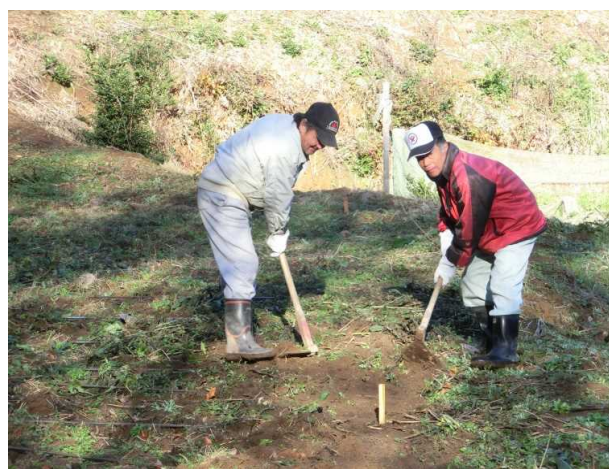
設置部分の地ならし、重要な作業です
